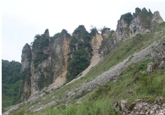
岩体被多组裂缝切割，稳定性差，极易发生崩塌 (贵州开阳，2006)
