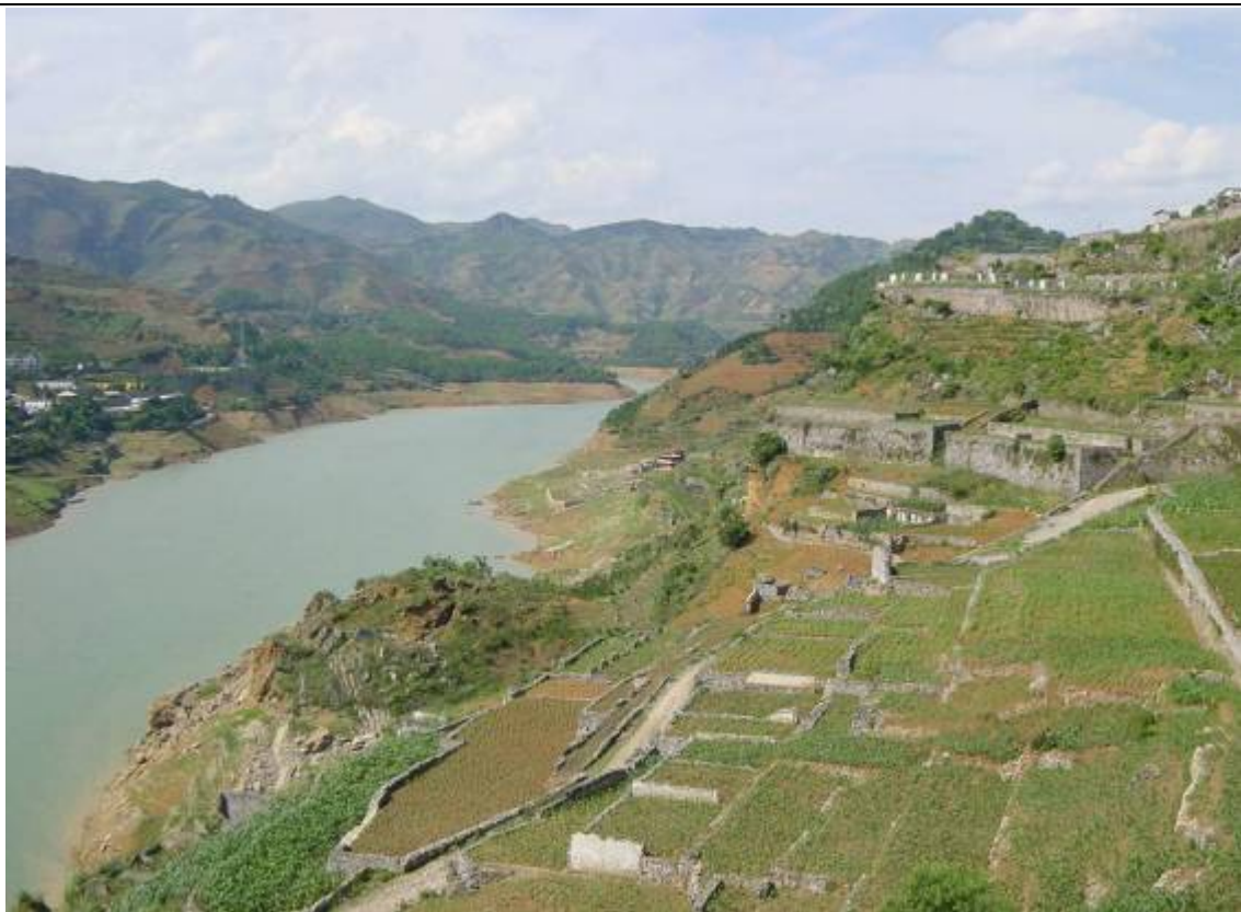
移民新址坐落在古滑坡台阶上，库水位下降后诱发滑坡，危及村庄 (鲁布革电站贵州库区, 2001)
