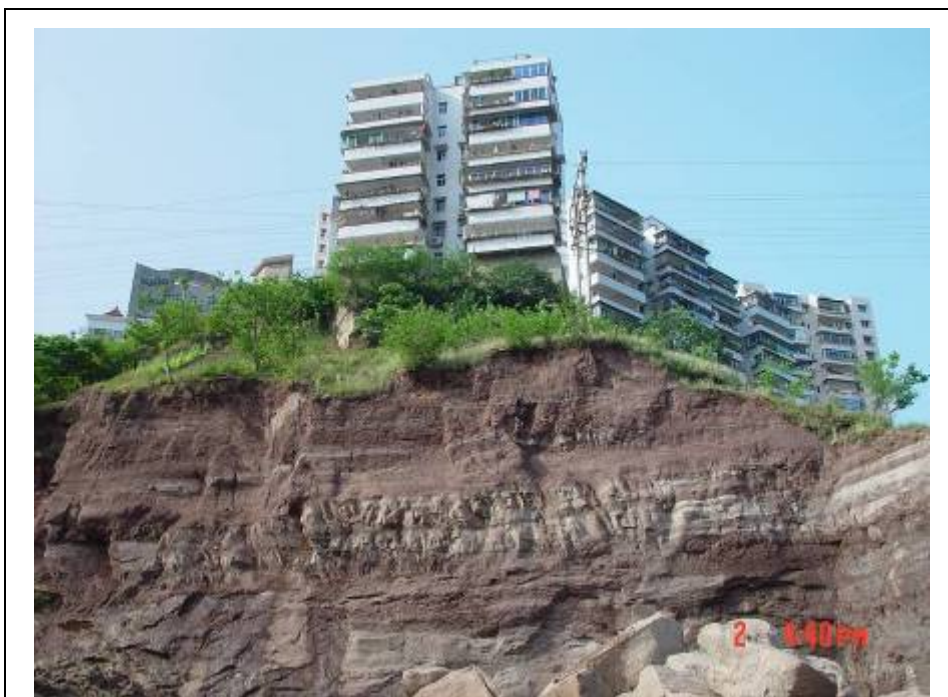
重庆云阳新城场地由砂岩泥岩互层，开挖后易于滑动 (2002)
