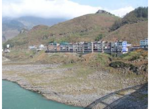
新房屋修建在稳定的基岩斜坡上 (重庆武隆, 2006)
