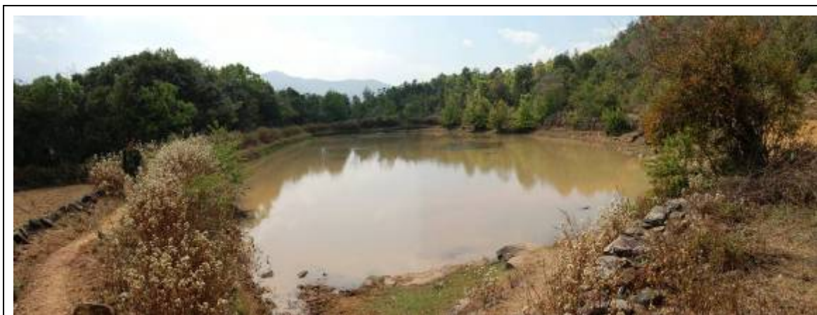
滑坡后缘洼地水塘未经防渗处理，池水易于渗入滑坡中，加剧变形(云南新平，2005)
