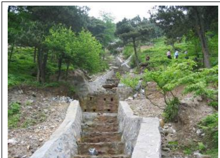
江西庐山泥石流防护工程 (2002)
