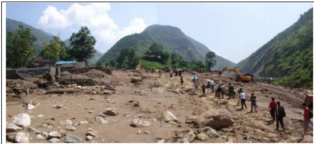
村庄挤占沟口，泥石流爆发时冲毁房屋，11人死亡（四川盐源，2006）
