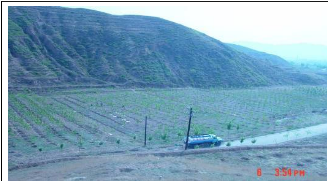
在泥石流沟谷中营造树林，可以减轻泥石流冲击力和稳固泥石流物源 (河北张家口，2004)
