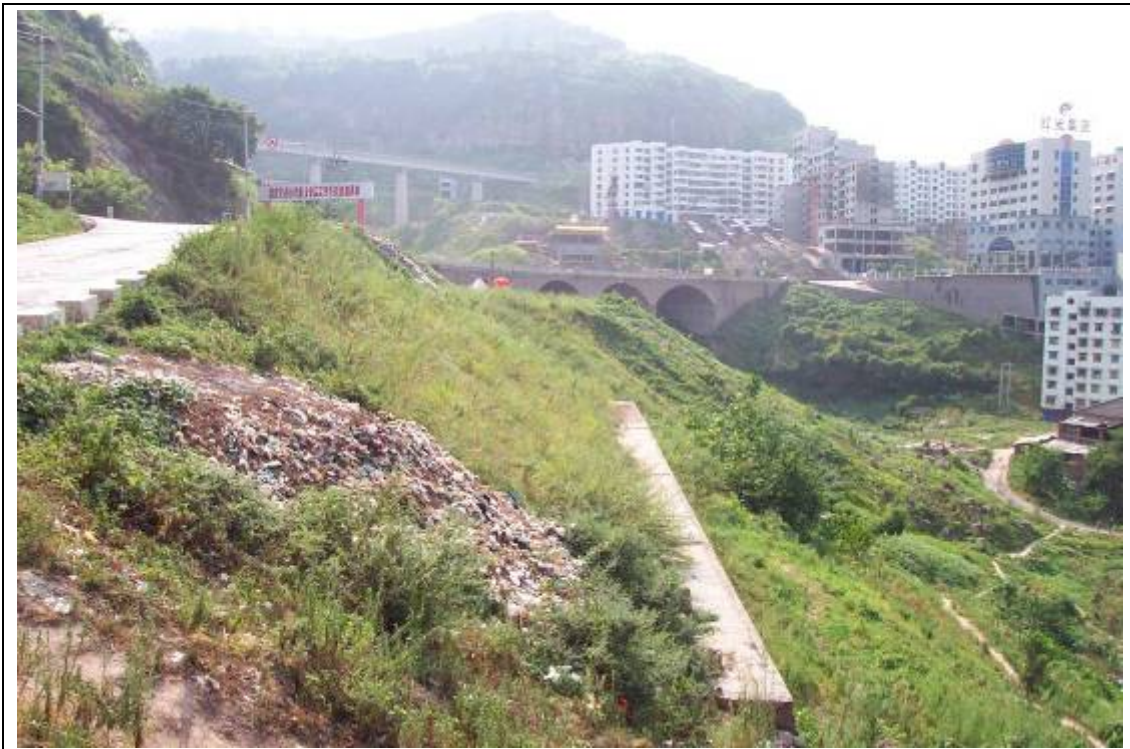
在滑坡后部随意排放渣石弃土，使滑坡稳定性明显降低，危及下方居民安全 (重庆万州关塘口滑坡，2002)
