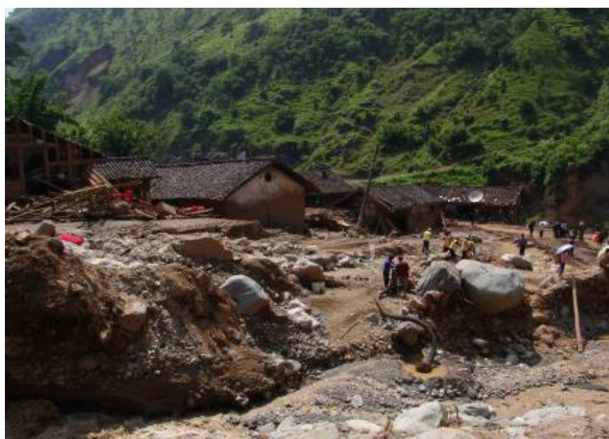
村庄建于冲沟沟口，泥石流爆发时冲毁房屋，11人死亡(四川盐源，2006)
