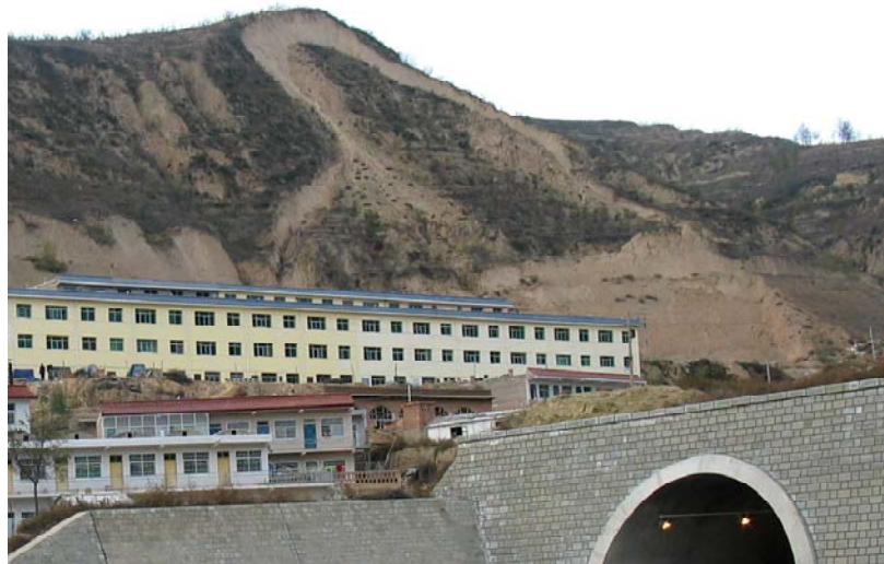
后缘出现明显的弧形下错裂缝，显示滑坡将整体滑动(陕西延安，2006)
