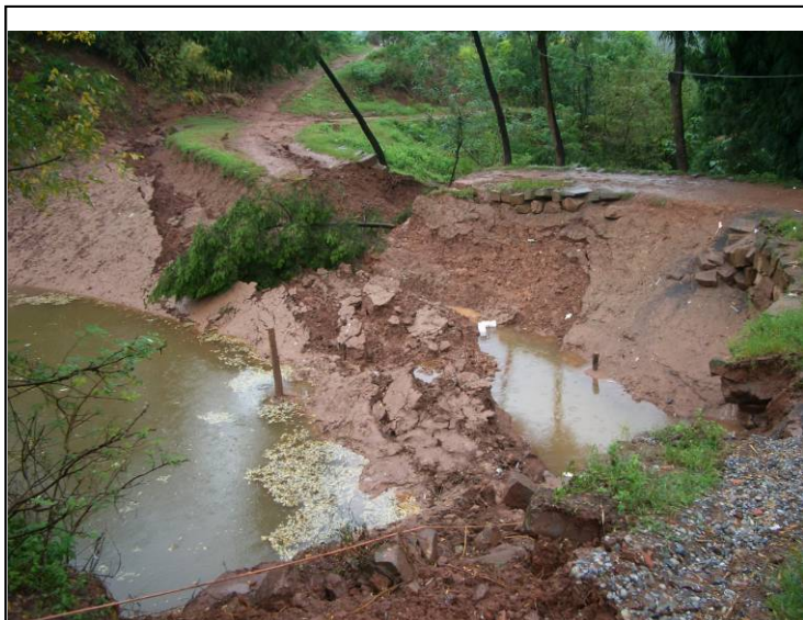
滑坡出现裂缝导致池塘水位明显下降(四川宣汉,2004)
