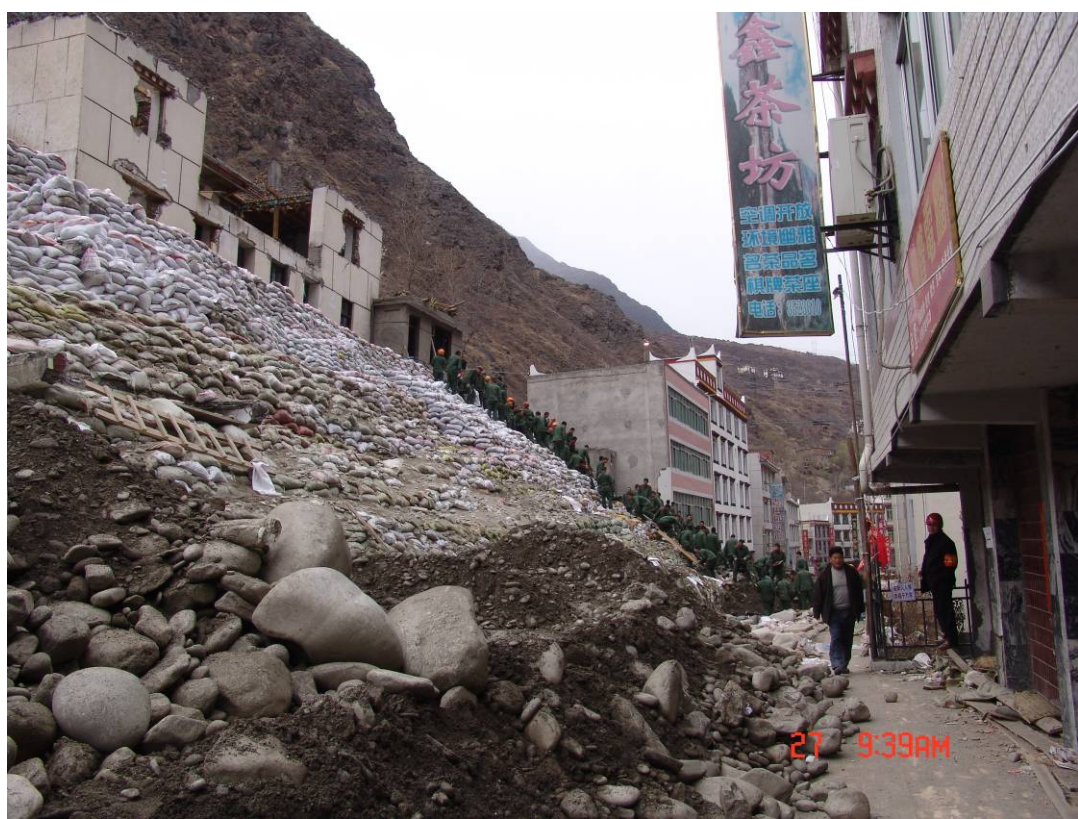
在前缘紧急放置沙袋压脚，有效减缓了滑坡变形滑移，避免了一场灾难(四川丹巴,2005)
