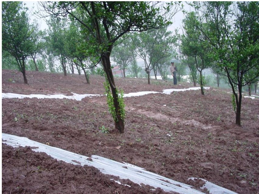
利用塑料布铺盖滑坡后缘拉裂缝,防止雨水直接渗入(重庆云阳,2000)
