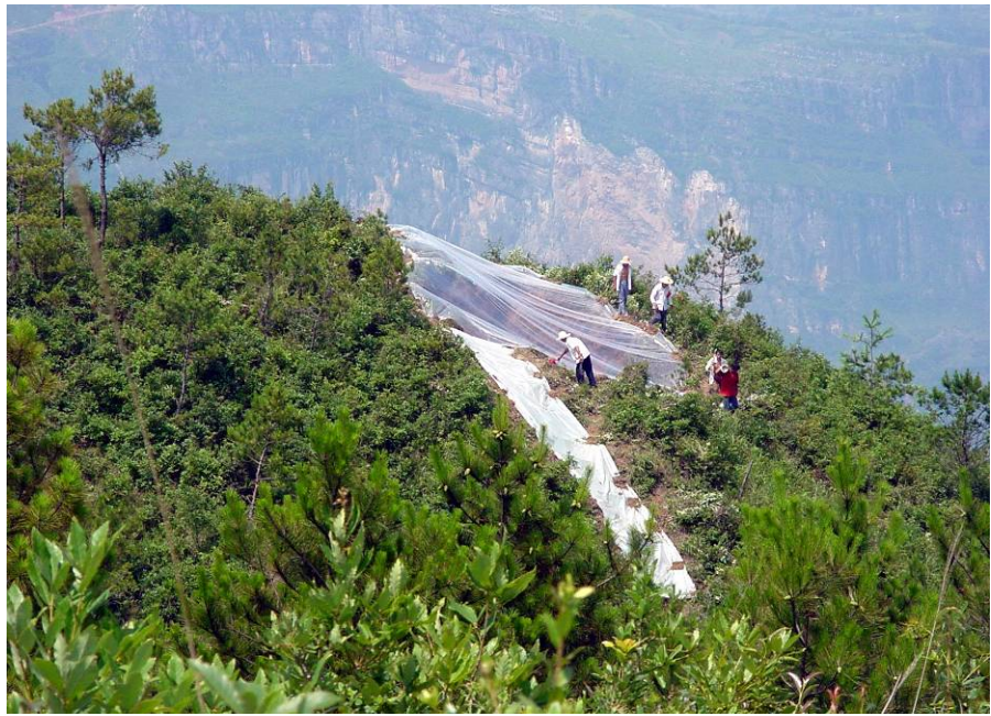
利用塑料布铺盖危岩体裂缝和落水洞，避免降雨直接灌入(重庆巫山,2000)
