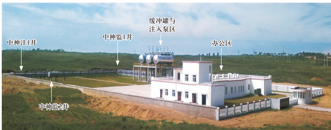
图5-6 鄂尔多斯盆地二氧化碳地质储存示范工程综合监测体系
