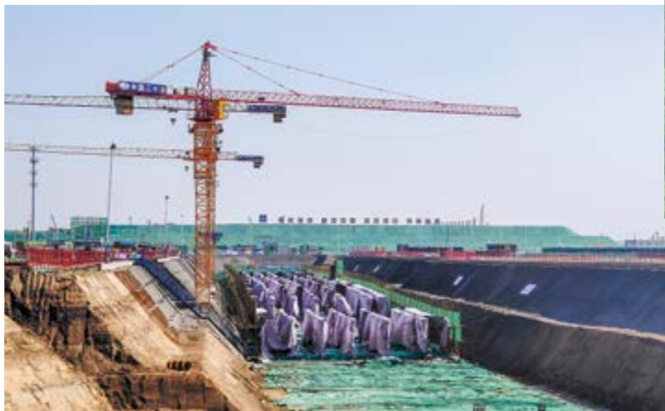
雄安新区容东 AF 社区项目施工现场
